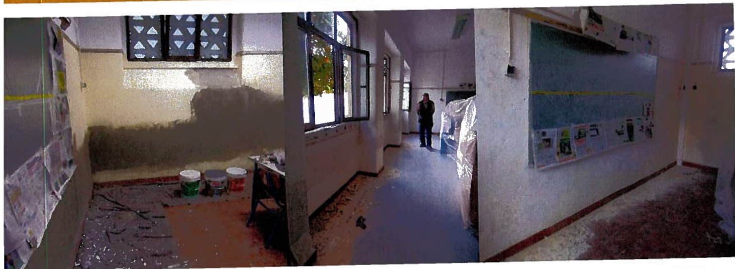
Pintura e tratamento de paredes do átrio da Escola Básica nº3
